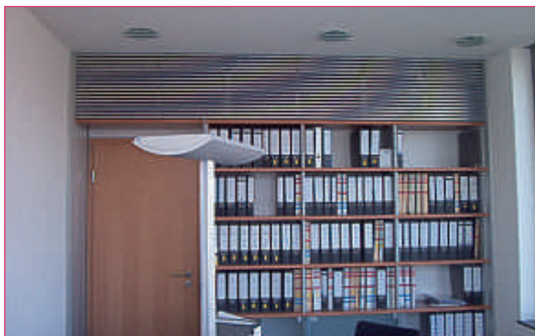
Schrankeinbaulösung zur Kühlung und Entfeuchtung.
