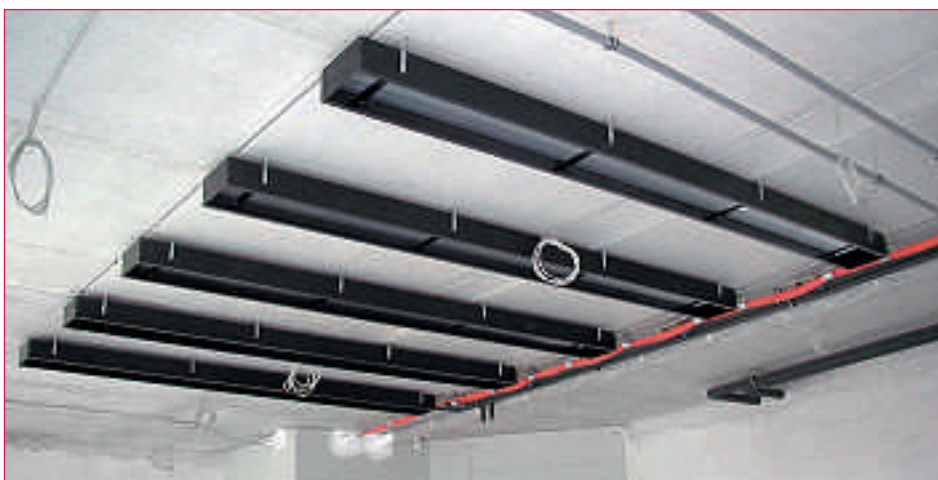
Kühlkonvektoren in der Rohinstallation.
