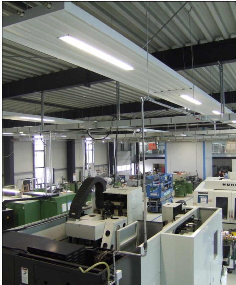
Energiesparende Hochleistungsdeckenstrahlplatten mit integrierter Beleuchtung
